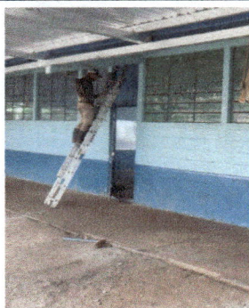
Foto 5: Mantenimiento de puertas
