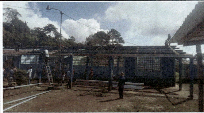
Foto 2: Cambio de lámina del corredor
