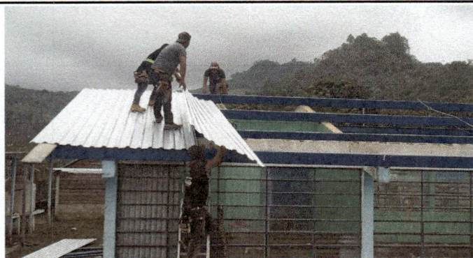
Foto1: Instalación de lámina troquelado
