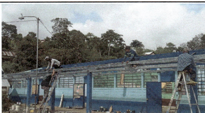
Foto 3: Instalación de costaneras del corredor
