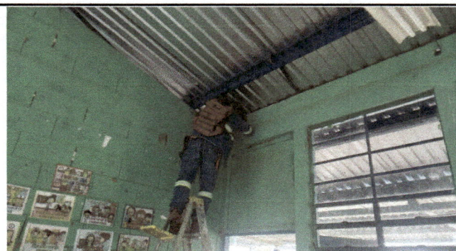
Foto 6: Reparación de sistema eléctrico.
